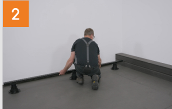
Konterlattung positionieren
