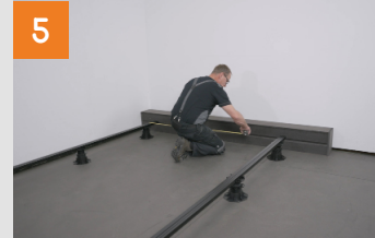
Konterlattung positionieren
