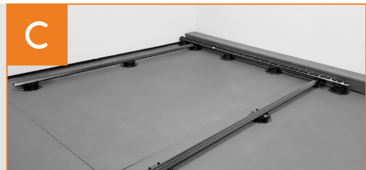
Erste Systemschiene positionieren
