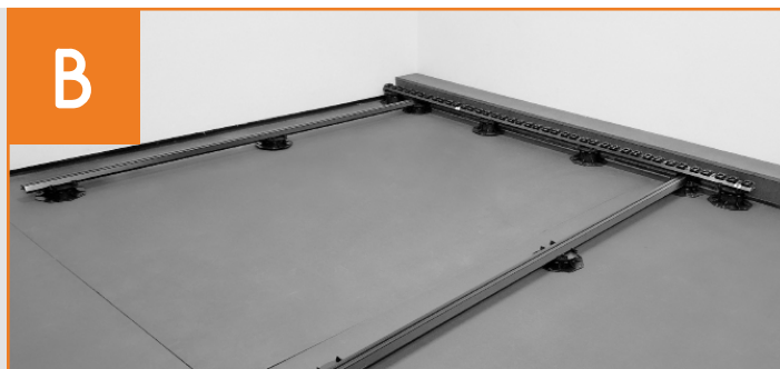
Erste Systemschiene positionieren
