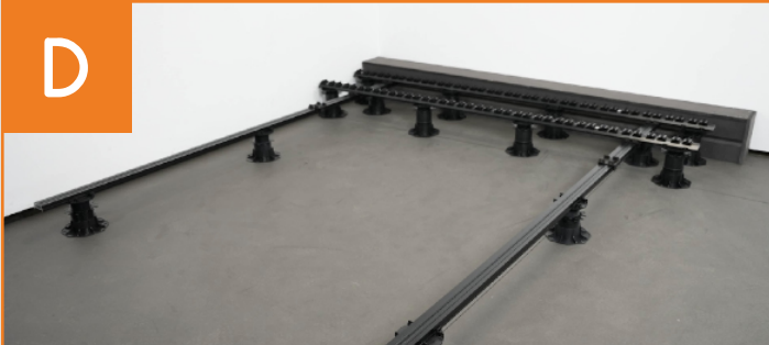
Systemschiene verlegen
