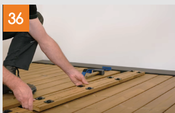
Diele herausnehmen und wieder einsetzen
