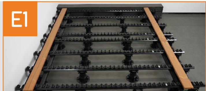
Erste und zweite Diele montieren
