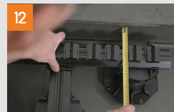
Erste Systemschiene positionieren
