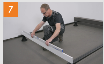
Konterlattung in Waage ausrichten
