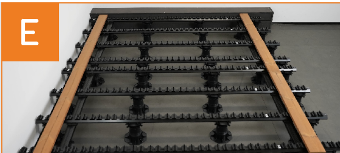
Erste und zweite Diele montieren
