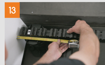
Erste Systemschiene positionieren
